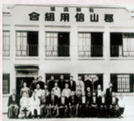
事務所拡張工事を祝って (昭和6年)
